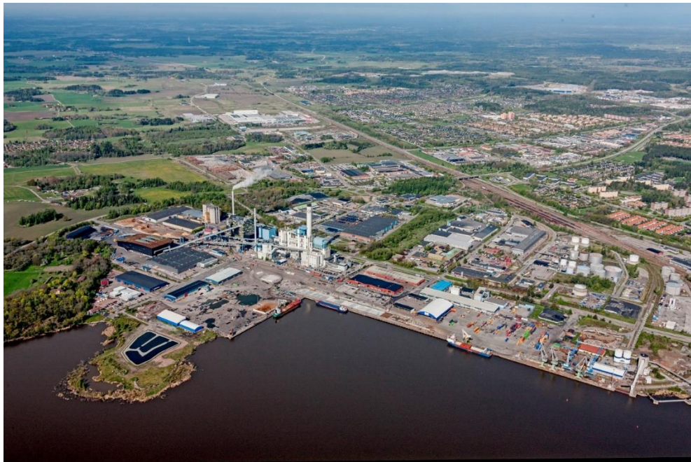
Figur 4. Vy över planområdet från Mälaren mot nordväst. Närmast syns hamnen och Kraftvärmeverket. T. h. ligger Sjöhagens industriområde med bland annat oljedepåer och stickspår från Mälarbanan. Centralt i fonden syns Hacksta industriområde med ICA:s centrallager. T. v. ligger flygfältsbyggnaderna tillhörande Johannisbergs flygfält. Bortom dem ligger Gränsta koloniområde och ytterligare längre bak i fonden ans Lundby kyrkby.
